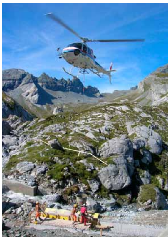
Wasserfassung mit Blick auf Flimsenstein und Tschingelhörner
